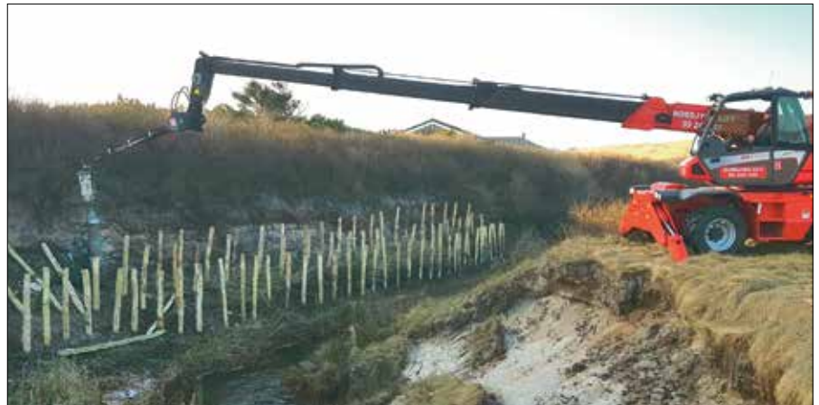
Vores specialmaskiner sparer tid og penge. Her en hydraulisk pælehammer på kran.
